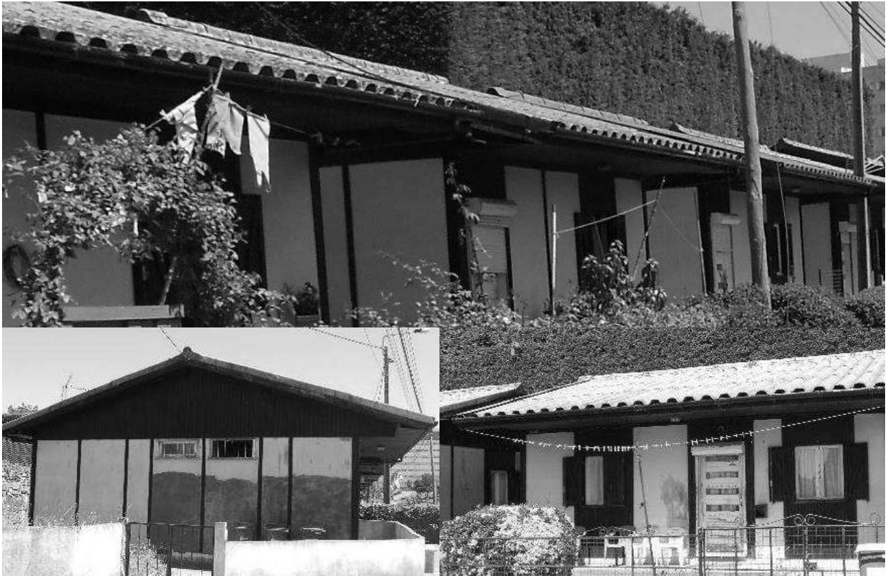
Imagem 5: Outras construções pré-fabricadas similares às instaladas no Bairro da Sra. da Graça. 6
