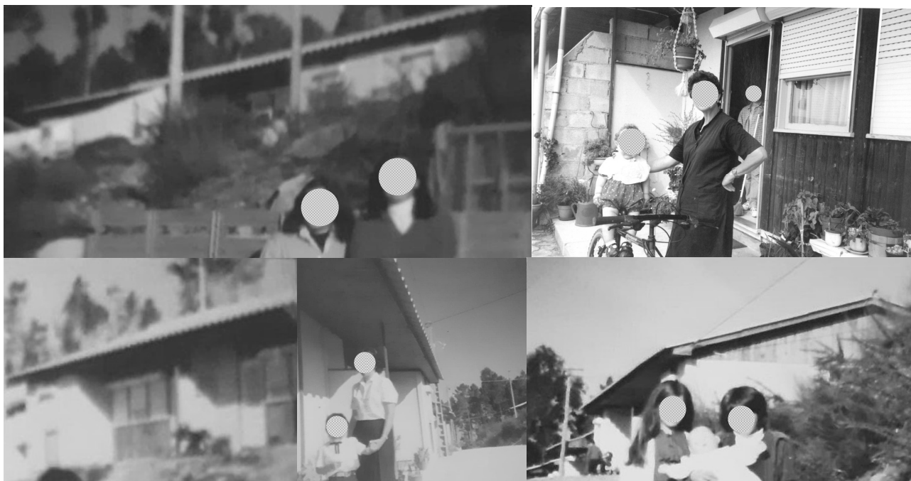
Imagem 4: Construções pré-fabricadas instaladas no Bairro da Sra. da Graça. 5
